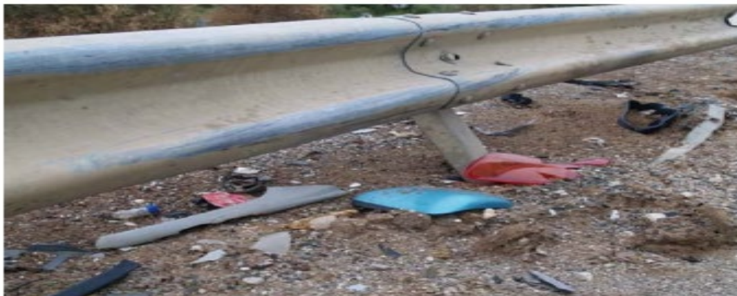
Σχήμα 91 Σύγκρουση της οροφής στο μεταλλικό στηθαίο και έναρξη περιστροφής προς τη θέση με τροχούς στο οδόστρωμα πριν τη σύγκρουση .
