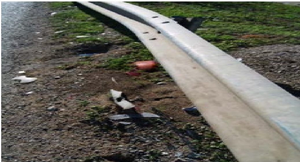
Σχήμα 32 Η σκηνή του ατυχήματος στη Χ.Θ. 34,200 της Ν.Ε.Ο. Πατρών-Πύργου, το σημείο σύγκρουσης του SUZUKI SX 4x4 με το μεταλλικό στηθαίο στο ρεύμα κυκλοφορίας Πάτρα – Πύργος.
