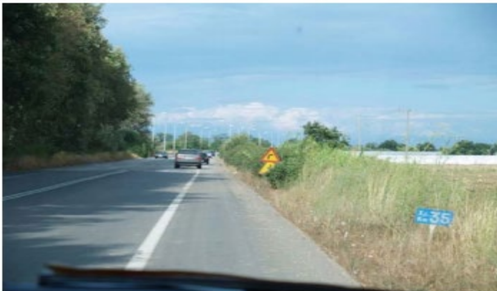
Σχήμα 6 Πινακίδες κατακόρυφης σήμανσης επικίνδυνη δεξιά στροφή, προσέγγιση σε ισόπεδο κόμβο, οι πινακίδες παρεμποδιζόμενες απο την βλάστηση και την ελλιπή συντήρηση της οδού
