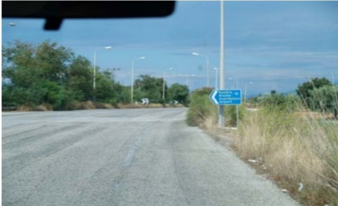
Σχήμα 10 Κατεύθυνση κίνησης του SUZUKI SX 4x4 : Νέα πινακίδα κατακόρυφης σήμανσης εμφανίζεται ξαφνικά - Η έκπληξη και η προσπάθεια του οδηγού για ανάγνωση είναι τώρα ακόμα πιο κρίσιμες για την οδική ασφάλεια στον κόμβο.
