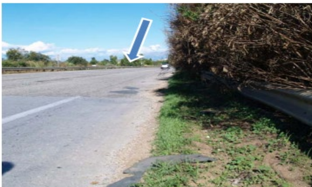
Σχήμα 16 Ασφαλτοτάπητας επισκευής διαφορετικού συντελεστή τριβής από το αρχικό οδόστρωμα-Σημείο σύγκρουσης των οχημάτων.
