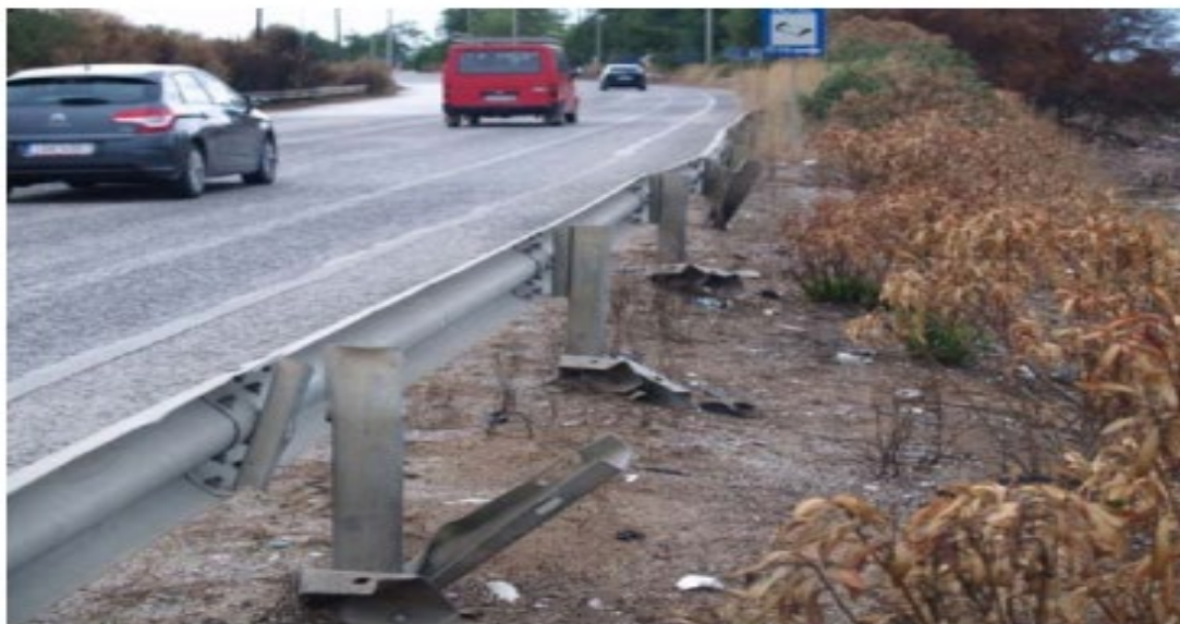
Σχήμα 22 Η σκηνή του ατυχήματος στη Χ.Θ. 34,200 της Ν.Ε.Ο. Πατρών-Πύργου, οι ορθοστάτες του μεταλλικού στηθαίου είναι οι τρίτοι κατά σειρά εγκατάστασης, η φορά κάμψης των παλαιότερων ορθοστατών ακολουθεί την κατεύθυνση Πύργος-Πάτρα
