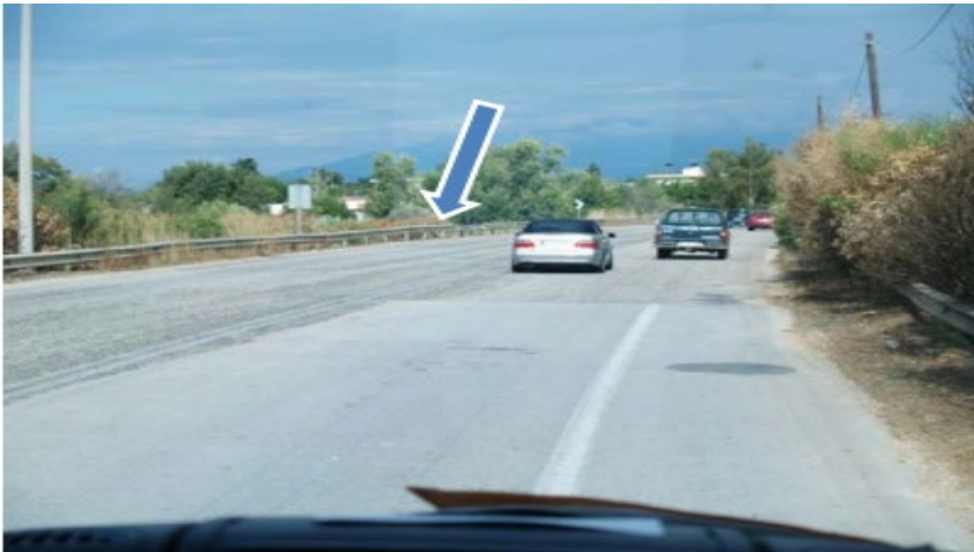
Σχήμα 15 Αλλαγή του συντελεστή τριβής στο οδόστρωμα - Σημείο πρώτης επαφής του SUZUKI SX με το μεταλλικό στηθαίο.
