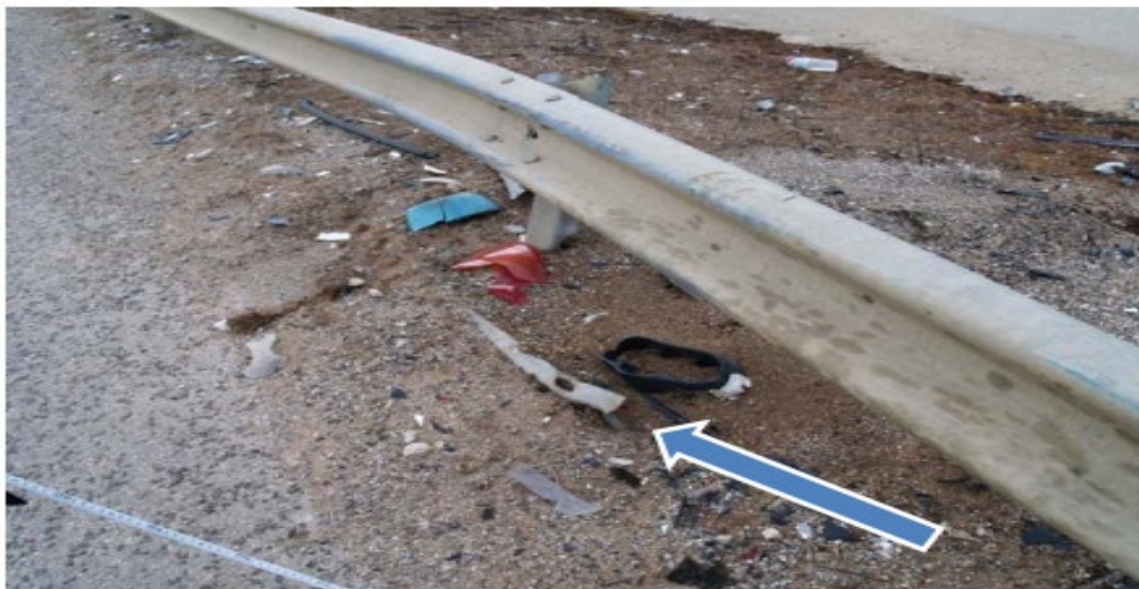
Σχήμα 84 Suzuki SX4, σύγκρουση της οροφής στο μεταλλικό στηθαίο και έναρξη ανατροπής.
