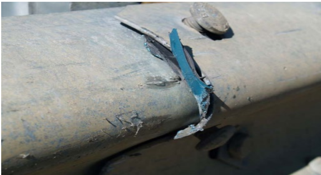
Σχήμα 80 Επαφή του οπίσθιου προφυλακτήρα με το μεταλλικό στηθαίο.
