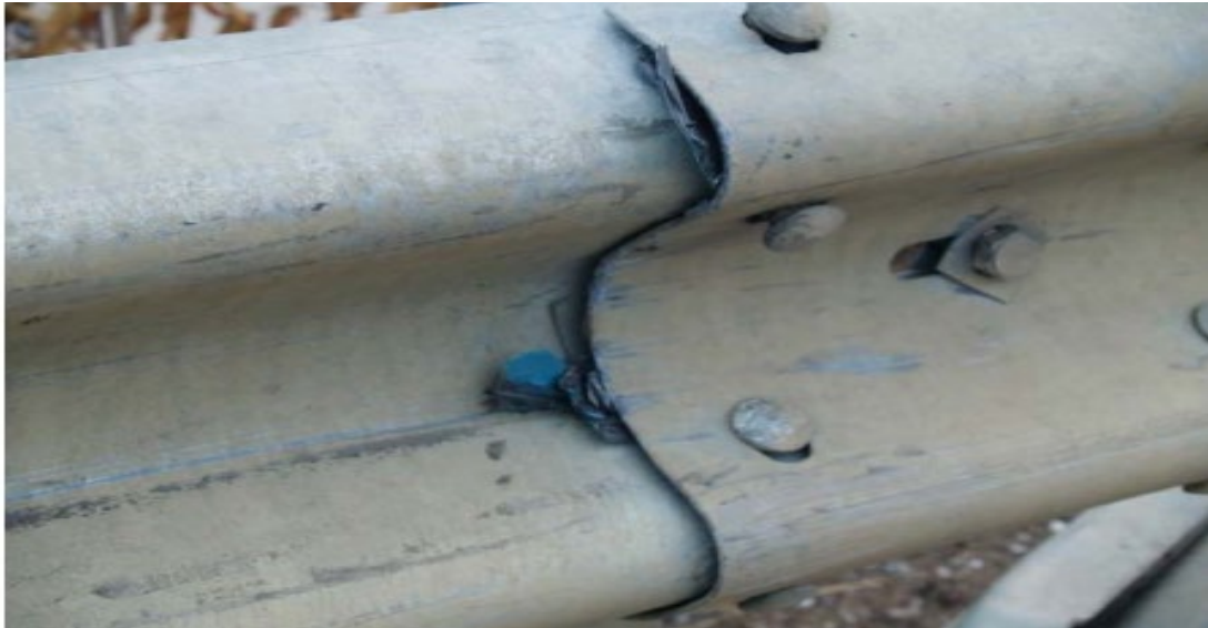
Σχήμα 79 Επαφή του οπίσθιου προφυλακτήρα με το μεταλλικό στηθαίο.
