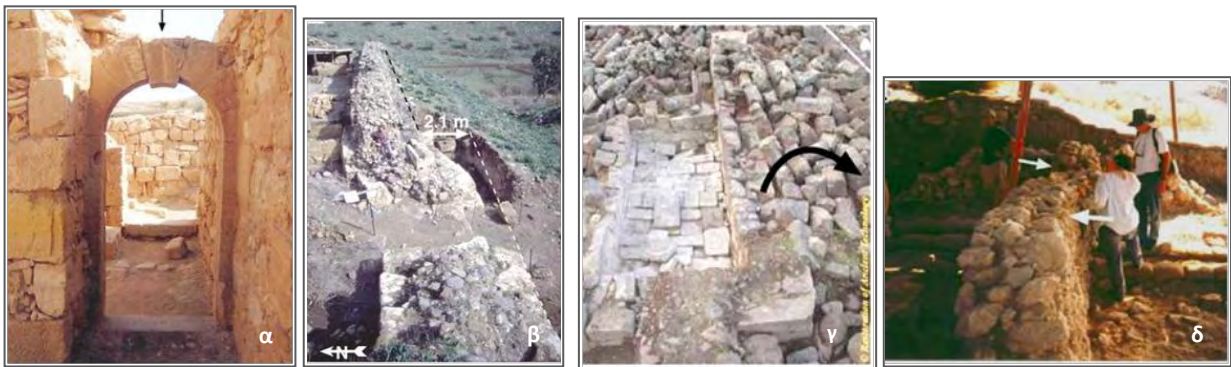
Εικόνα 4: Χαρακτηριστικές σεισμικές επιπτώσεις σε αρχαίες θέσεις. α) Ολίσθηση κλειδόλιθου σε αψίδα. β) Διαρρηγμένος και μετατοπισμένος τοίχος λόγω ρήγματος. γ) Προσανατολισμένη και οριοθετημένη κατάρρευση τοίχου (imbricate arrangement). δ) Σιγμοειδής στρέβλωση τοίχου. (Πηγή: Marco, 2008)
