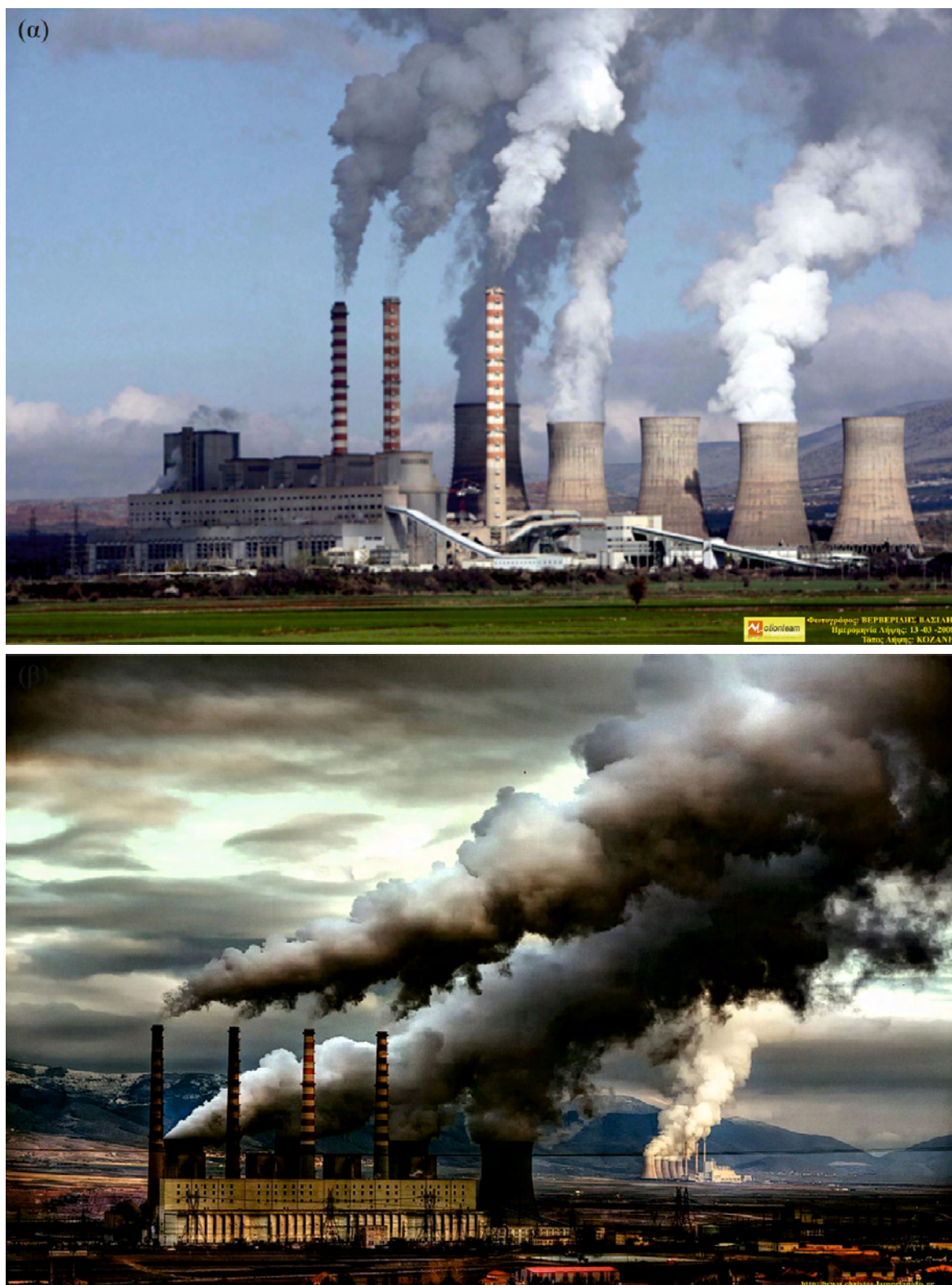
Σχήμα 1.4 Πεδίο ροής και διάχυσης καπναερίων από πύργους ψύξης και καμινάδες (α) Ατμοηλεκτρικό Εργοστάσιο ΔΕΗ - Άγιος Δημήτριος Πτολεμαΐδας [Πηγή: http://www.motionteam.gr ] (β) Ατμοηλεκτρικό Εργοστάσιο ΔΕΗ - Καρδιά Κοζάνης [Πηγή: http://www.neoiellispontou.blogspot.gr201009blog-post_21.html ]
