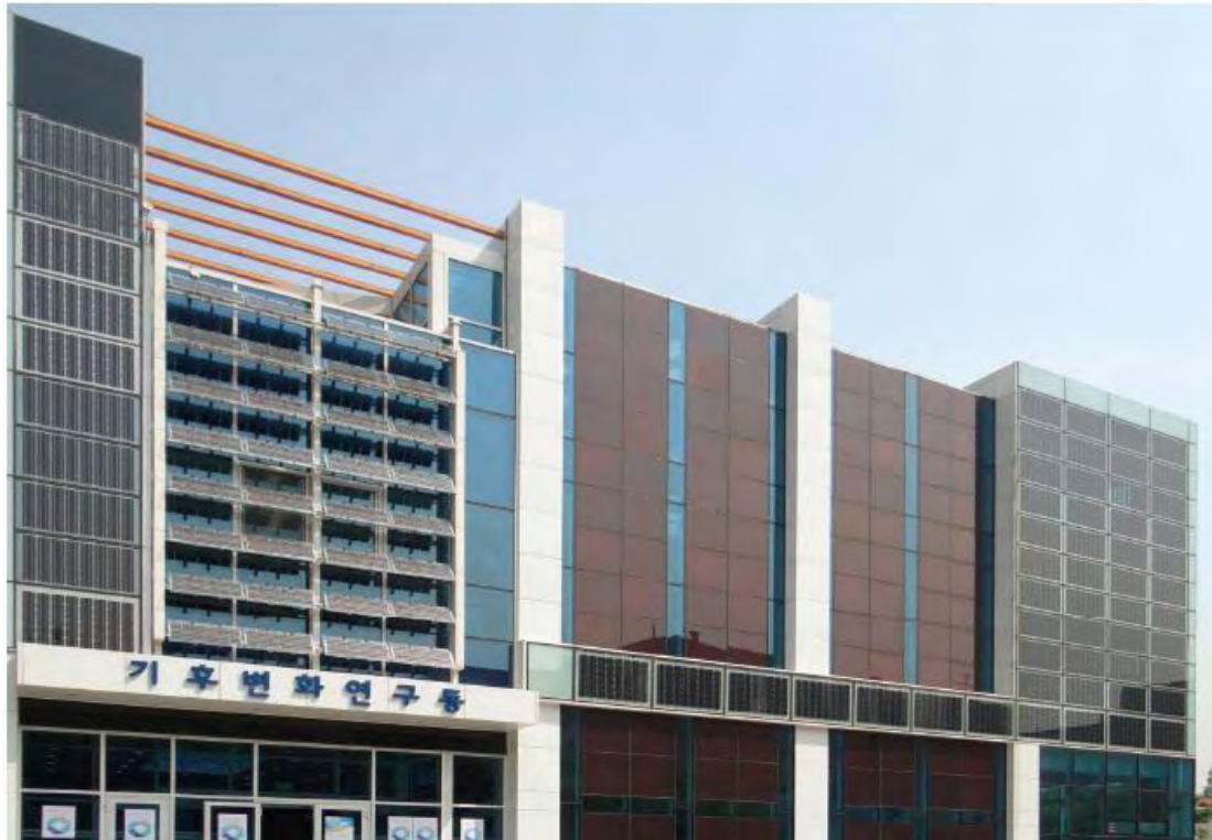
Εικόνα 3-2. Παράδειγμα “technical” integration με καθεαυτού ενσωμάτωση φ/β στοιχείων στην πρόσοψη κτιρίου (“Climate Change Research Building”, Incheon, South Korea) [11]
