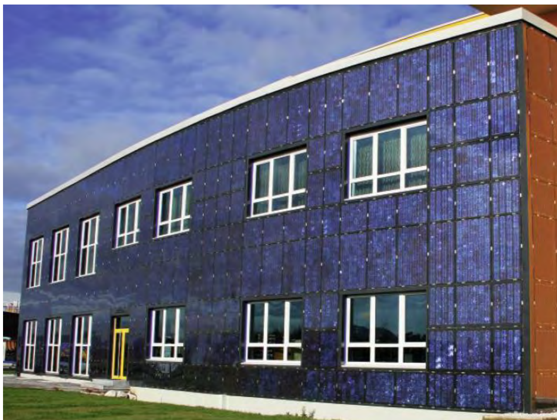
Εικόνα 5-13. Πρόσοψη κτιρίου στην Αυστρία με 245 πλαίσια EFL διαφόρων διαστάσεων της εταιρείας Ertex Solar. [112]
