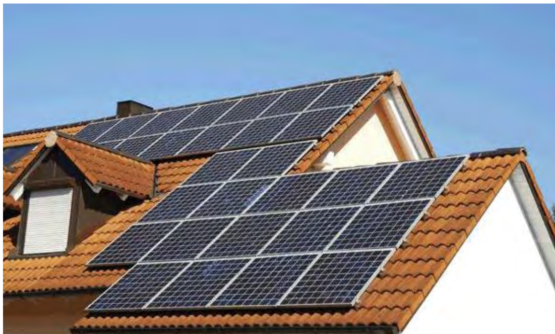
Εικόνα 3-23. Χρήση στάνταρ φ/β πλαισίων με περίβλημα για εγκατάσταση σε στέγη [100]
