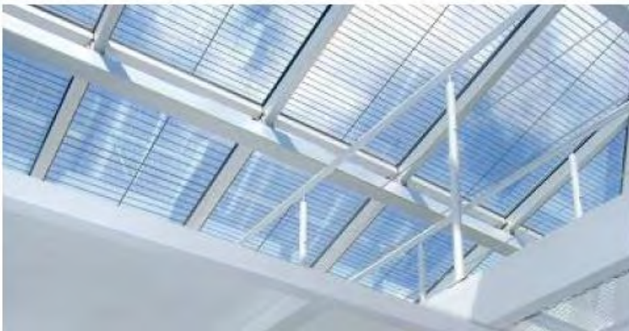
Εικόνα 3-26. Χρήση φ/β πλαισίων σε μορφή υαλοπίνακα για ενσωμάτωση σε στέγη [106]
