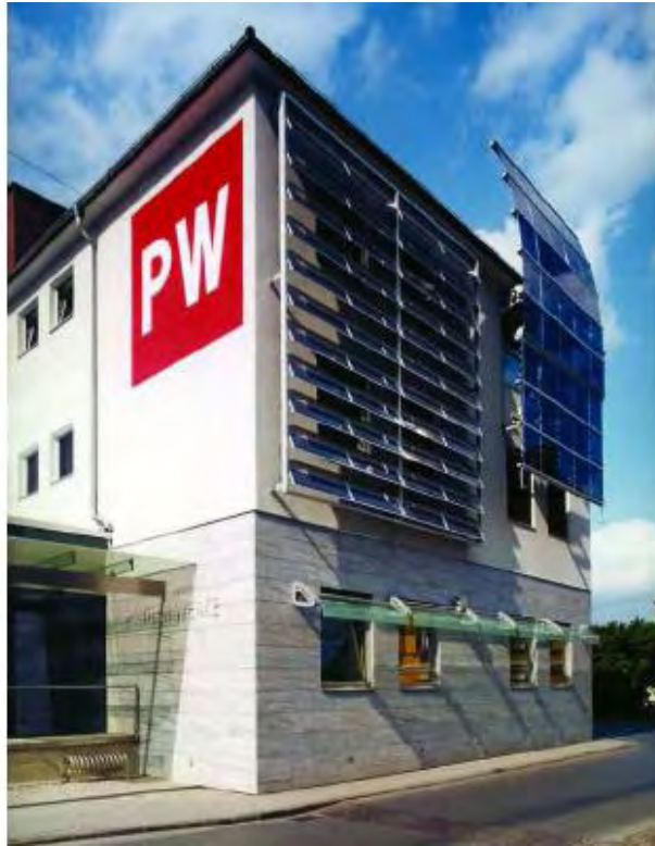
Εικόνα 3-35. Παράδειγμα ενσωμάτωσης φ/β στην πρόσοψη κτιρίου ως σκίαστρα μεταβλητής κλίσης (κινούμενες περσίδες) [19]
