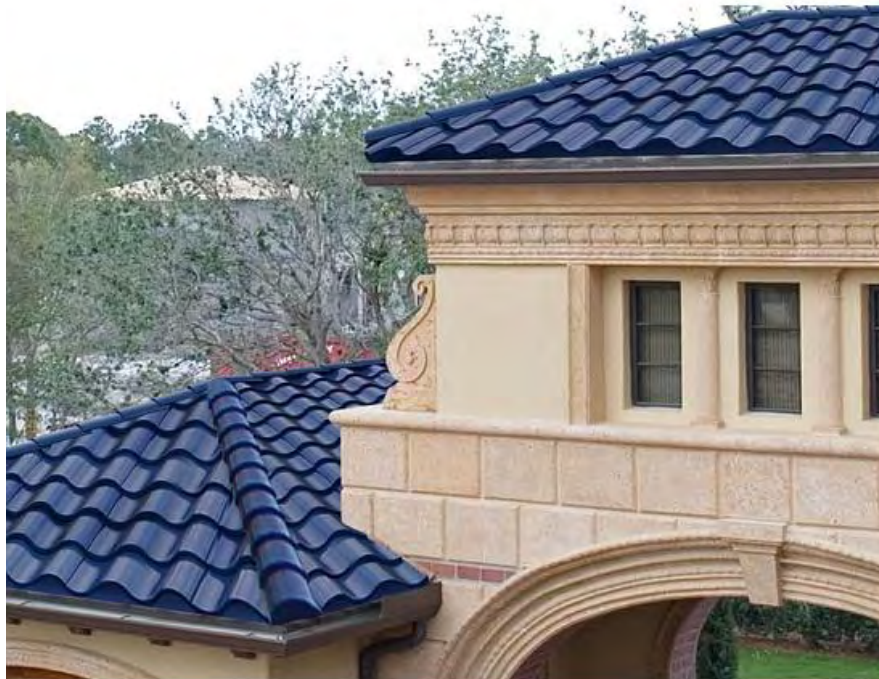
Εικόνα 3-27. Χρήση ηλιακών κεραμιδιών (solar tiles) για ενσωμάτωση σε στέγη [105]
