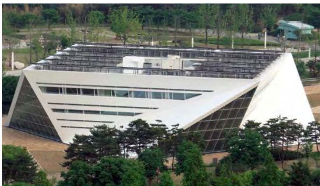
Εικόνα 3-1. Παράδειγμα “formal” integration με εγκατάσταση πρόσθετων φ/β στοιχείων στην οροφή κτιρίου (“Energy Dream Center”, Seoul, South Korea) [11]
