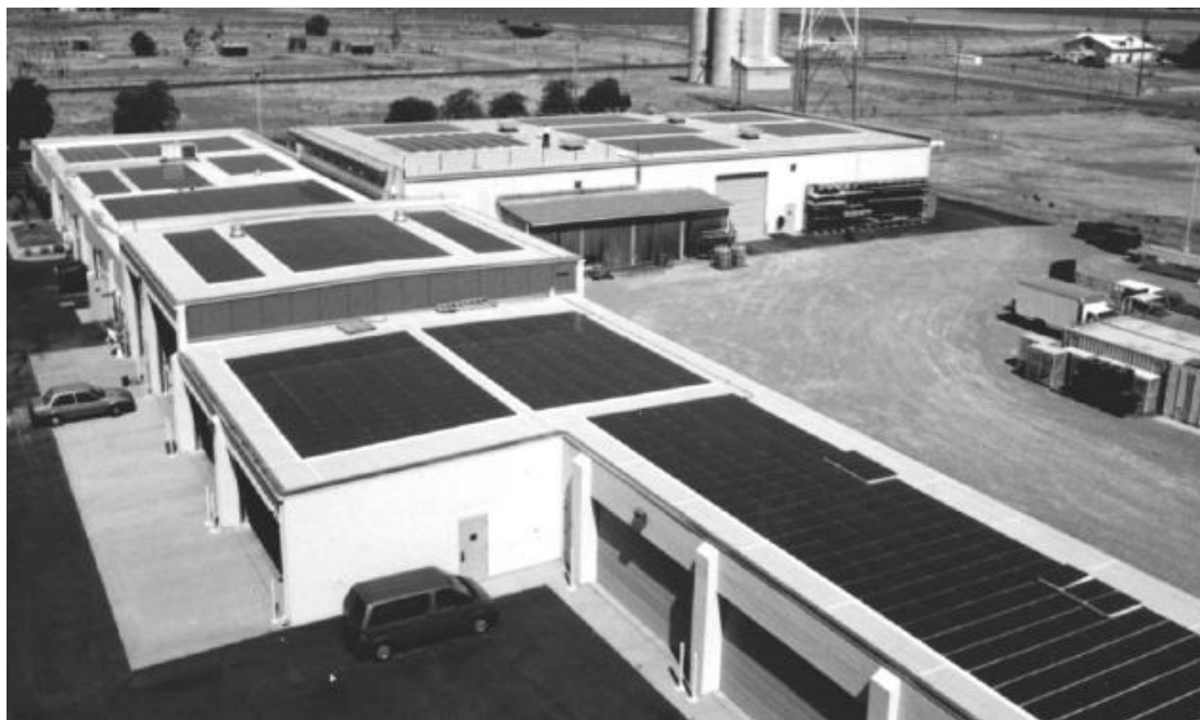
Εικόνα 3-38. Ολοκληρωμένη άποψη της εγκατάστασης ηλιακών κεραμιδιών στο κτιριακό συγκρότημα ιδιοκτησίας U.S. Department of Energy (DOE) Western Area Power Administration (περιοχή Elverta, California) [2]
