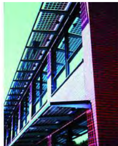
Εικόνα 3-34. Παραδείγματα φ/β πλαισίων στην πρόσοψη κτιρίου ως σκίαστρα σταθερής κλίσης [7]
