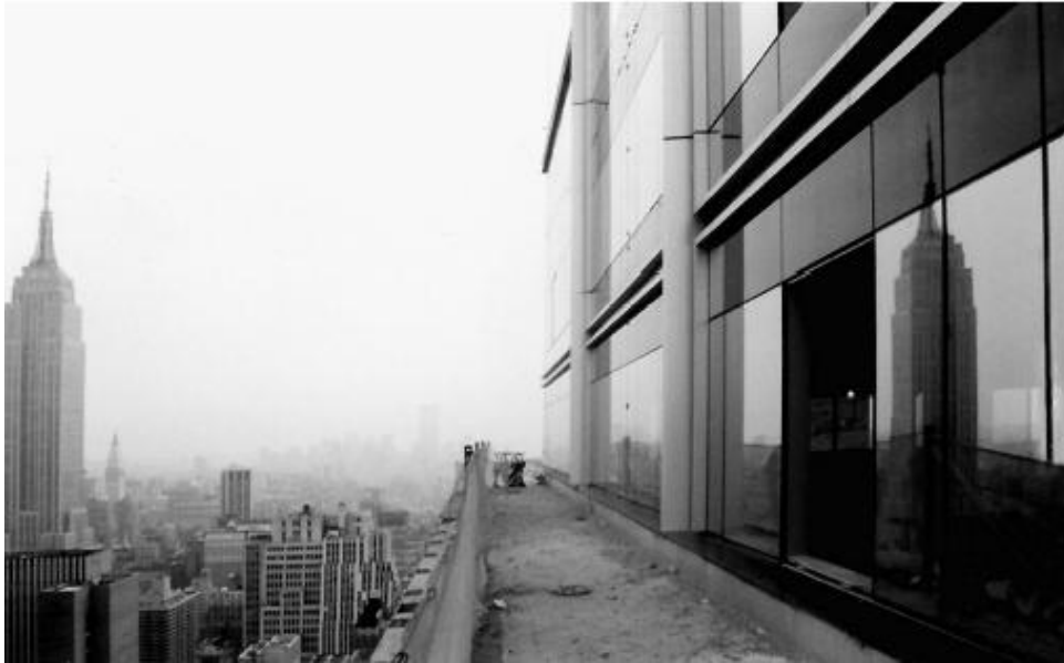
Εικόνα 3-44. Κοντινή άποψη πρόσοψης κτιρίου γραφείων ιδιοκτησίας Durst Corporation με τα ενσωματωμένα φ/β πλαίσια. [2]
