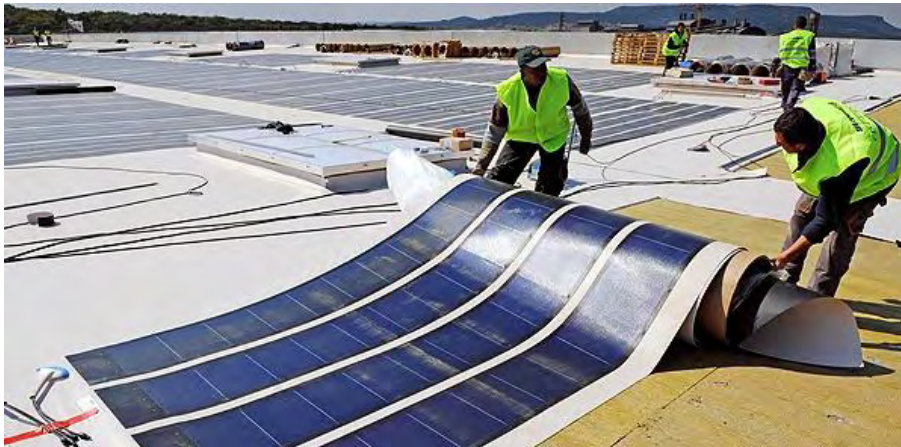
Εικόνα 3-25. Χρήση εύκαμπτων φ/β πλαισίων (σε ρολό), για εγκατάσταση σε στέγη [96]
