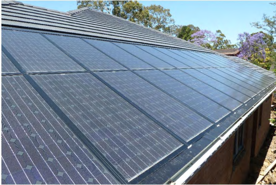
Εικόνα 3-24. Χρήση frameless solar panels για εγκατάσταση σε στέγη [90]
