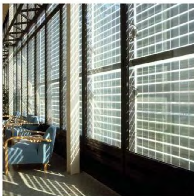
Εικόνα 3-43. Εσωτερική άποψη της πρόσοψης του κτιρίου της βιβλιοθήκης Pompeu Fabra, στην πόλη Mataró της Ισπανίας [5]
