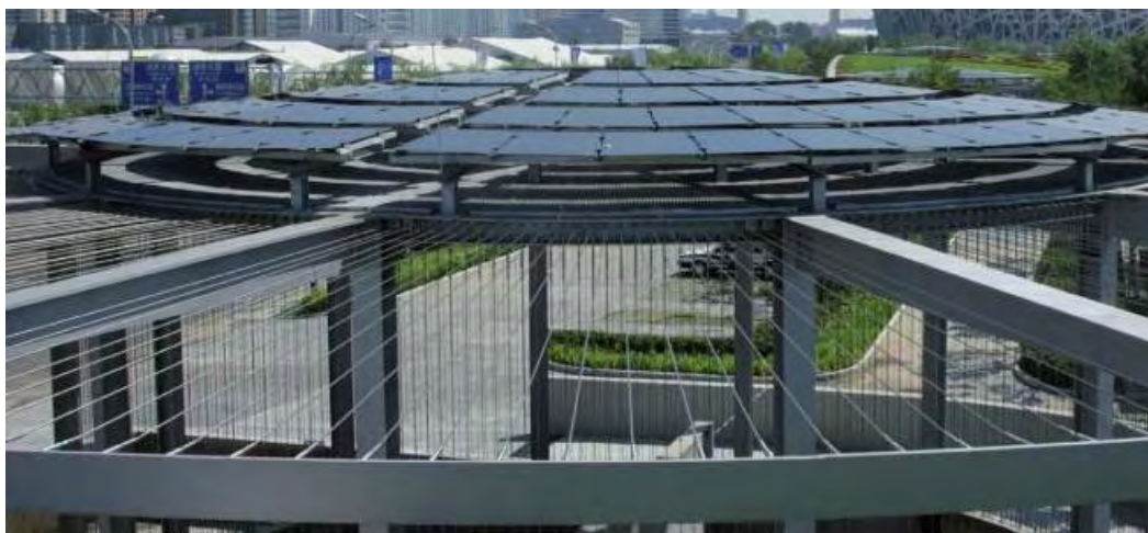
Εικόνα 3-47. Ολοκληρωμένη άποψη του στεγάστρου του Ολυμπιακού Πάρκου του Πεκίνου με τα ενσωματωμένα φ/β πλαίσια [5]
