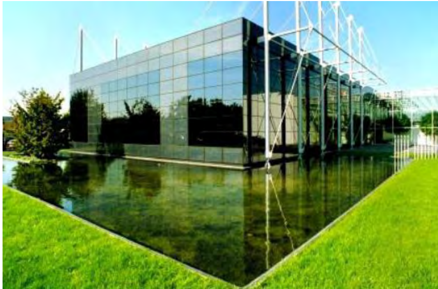
Εικόνα 3-33. Πρόσοψη SSG σε κτίριο της Γερμανίας [05]
