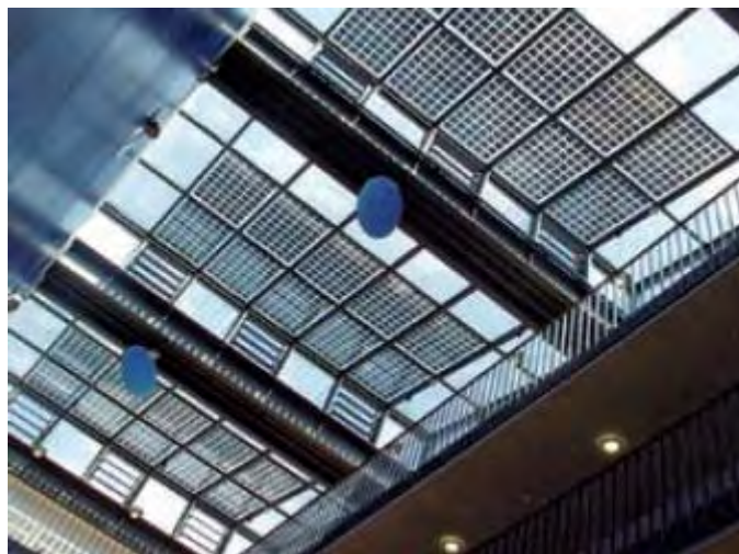
Εικόνα 3-21. Αντικατάσταση όλης της στέγης με φ/β [53]
