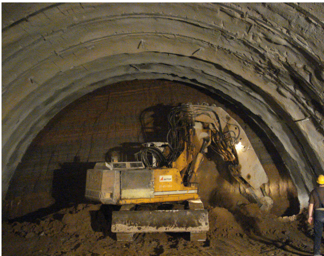
Εικ. 2 Διάνοιξη νέου μετώπου στην σήραγγα με χρήση τσάπας
