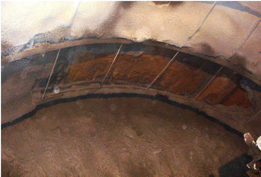
Εικ.4 Τελικό στάδιο ομπρέλας Spiles
