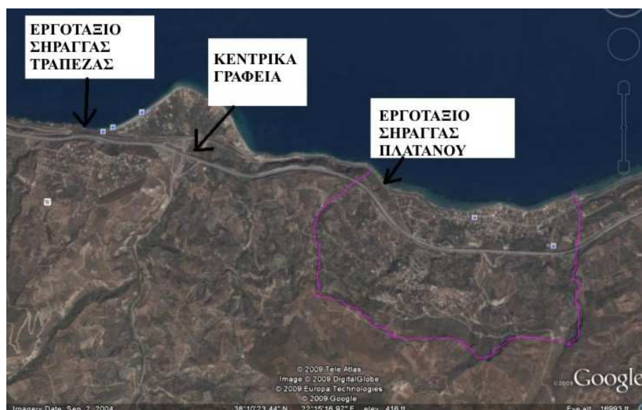
Εικ. 1 : Αεροφωτογραφία της περιοχής κατασκευής του έργου και επιμέρους τμήματά του
