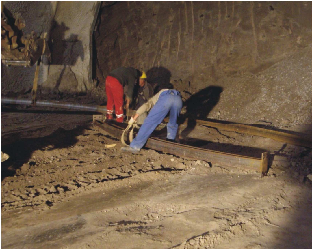
Εικ. 5 Τοποθέτηση μεταλλικών πλαισίων
