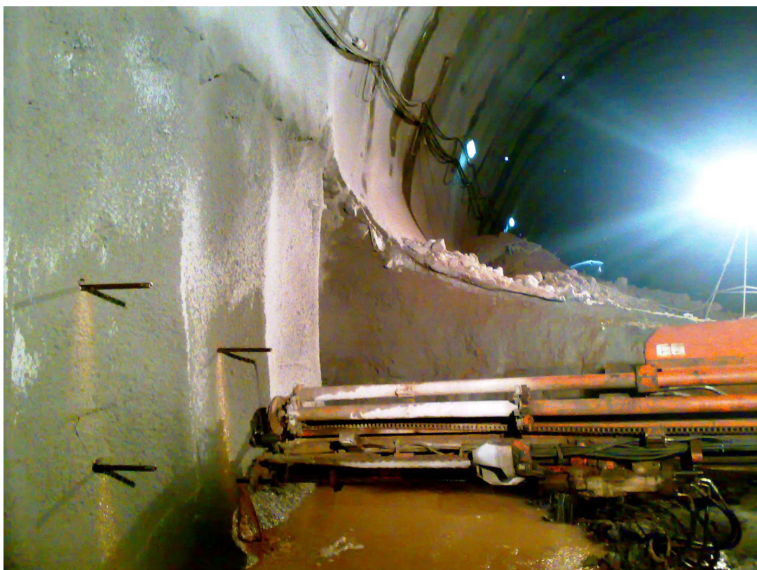
Εικ.6 Τοποθέτηση αγκυρίων και διαδικασία διάτρησης
