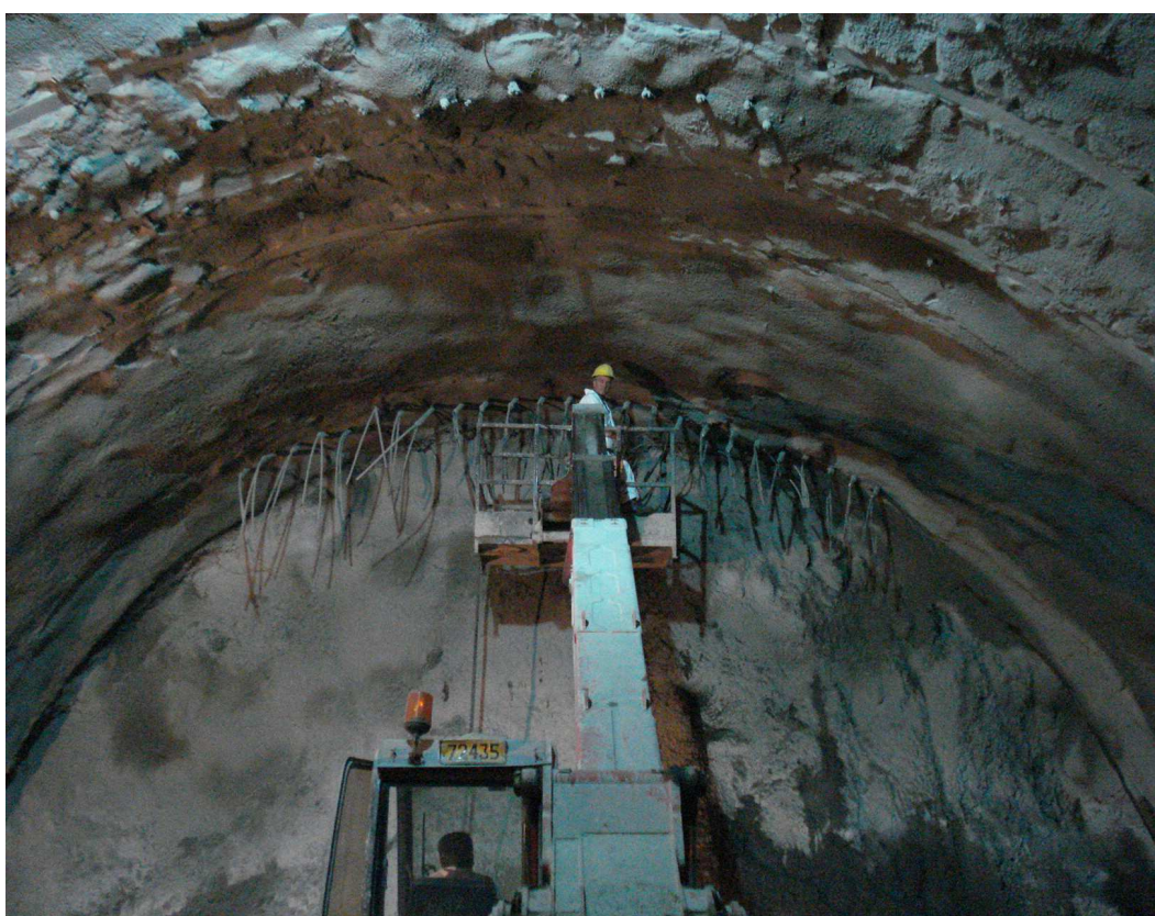
Εικ. 3 Διαδικασία τοποθέτησης Ομπρέλας Spiles
