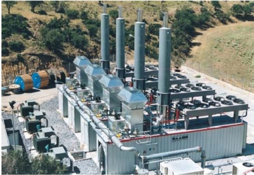
Εικόνα 3: Έργο εκμετάλλευσης του βιοαερίου στους Ταγαράδες Θεσσαλονίκης (Πηγή : www.anakyklosi.gr/.../Image/III_VIOAERIO.jpg )
